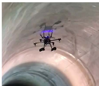
管頂部走行状況
