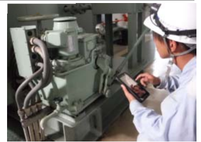
点検アプリを活用した 作業風景
