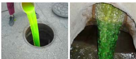
図. 染色法による管路接続調査
