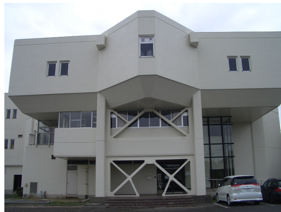
耐震補強工事完成
