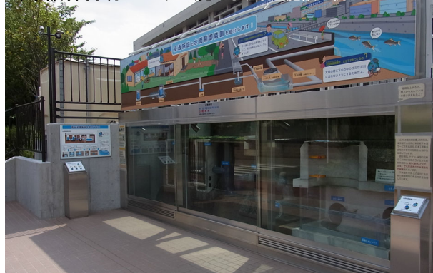
東京都浮間水再生センター(見える下水道施設の例)
