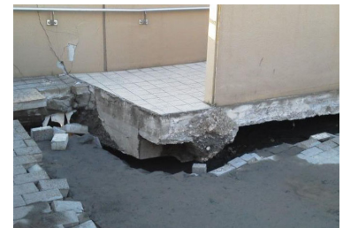
2011.3.11 東北地方太平洋沖地震による液状化の被害状況(千葉県浦安市内) 写真左)マンホールの浮き上がり 写真上)地盤(圧密)沈下
