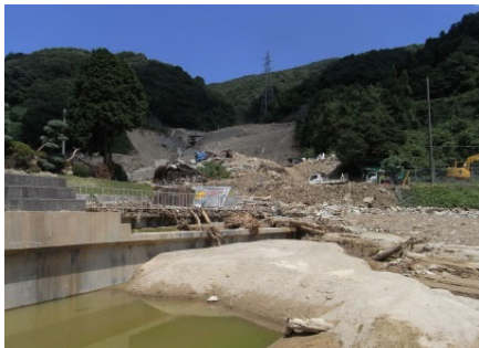
図1 広島県呉市水源地被災状況 (平成30年7月豪雨)
