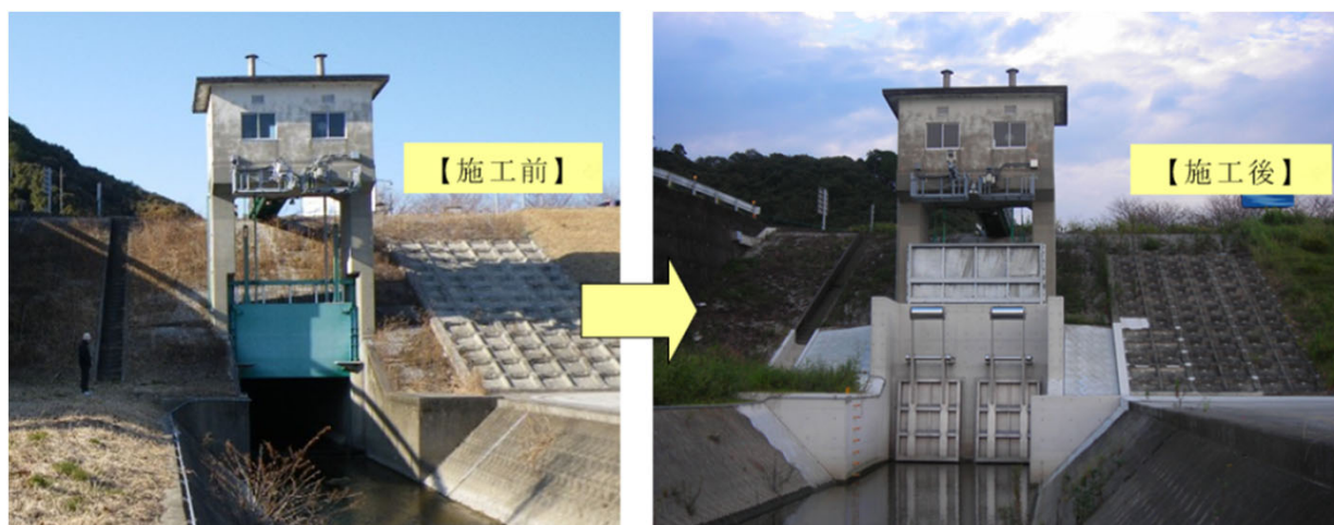
図3 樋門無動力化施工例(当社設計)
