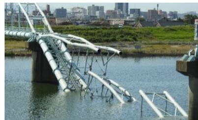
図1 六十谷水管橋崩落事故
