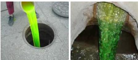
図. 染色法による管路接続調査
