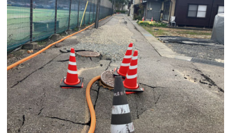
図12 応急仮復旧（仮ポンプ＋砕石設置）
