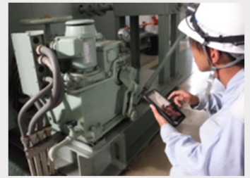
点検アプリを活用した作業風景
