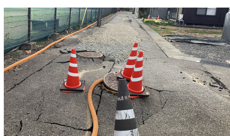
応急仮復旧(仮ポンプ+砕石設置)
