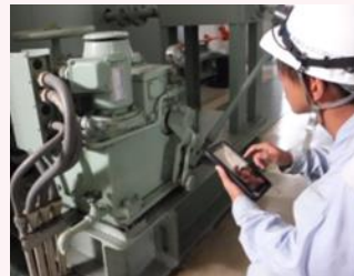
【点検アプリを活用した作業風景】
