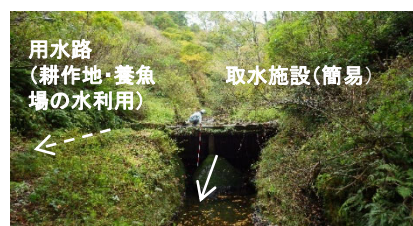
図3 工事中配慮の必要な施設(取水施設)
