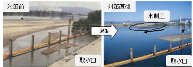
図1 水制工の設置による堆積土砂の除去
