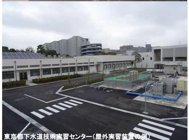
東京都下水道技術実習センター(屋外実習装置の例)
