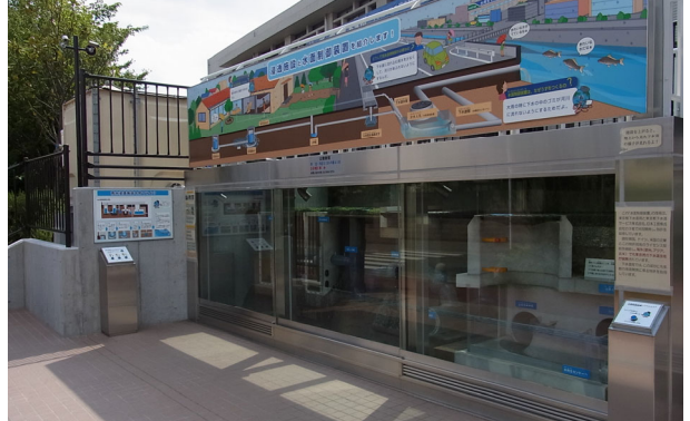
東京都浮間水再生センター(見える下水道施設の例)
