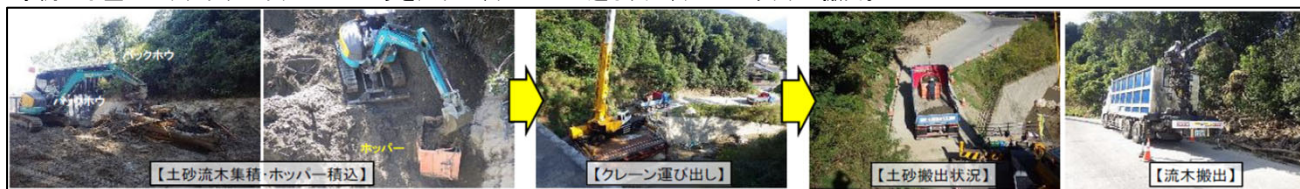
図3 土石流補足後の砂防堰堤の土砂撤去作業事例
